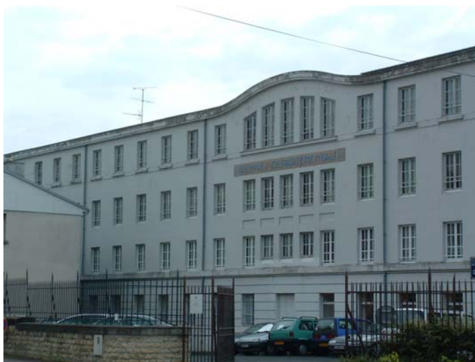
Le bâtiment actuel datant de 1927 avant le début des travaux
