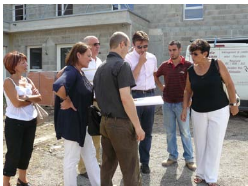
Visite de chantier maison de retraite de Fourchambault
