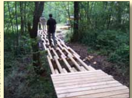
Réalisation du platelage
